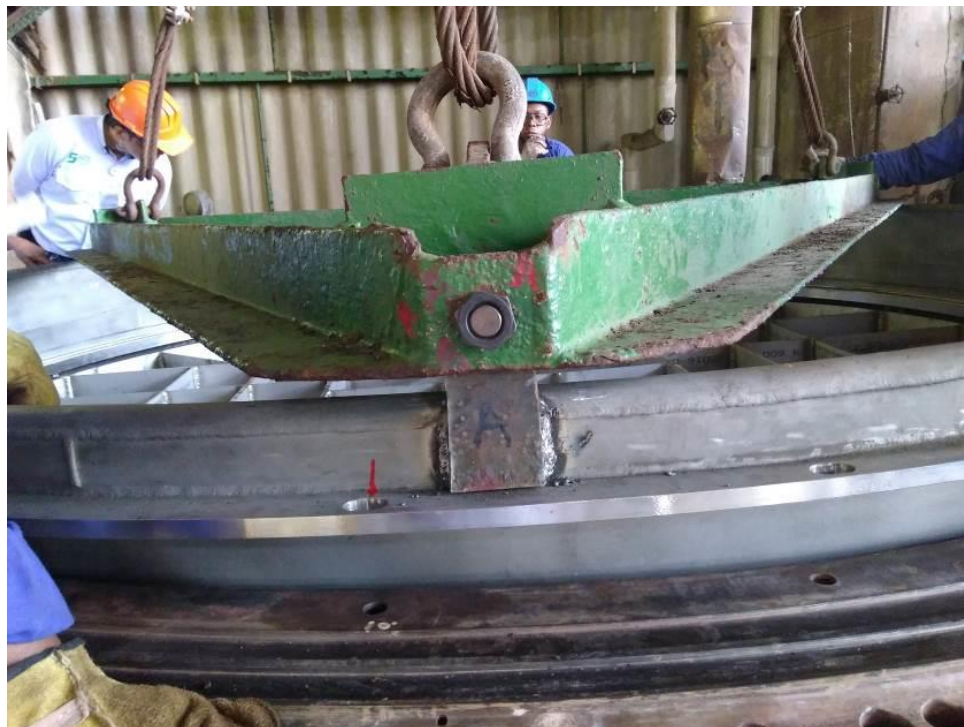
Foto 1: Punto de sujeción – Unión bridada de la canasta al Reactor R1101.
