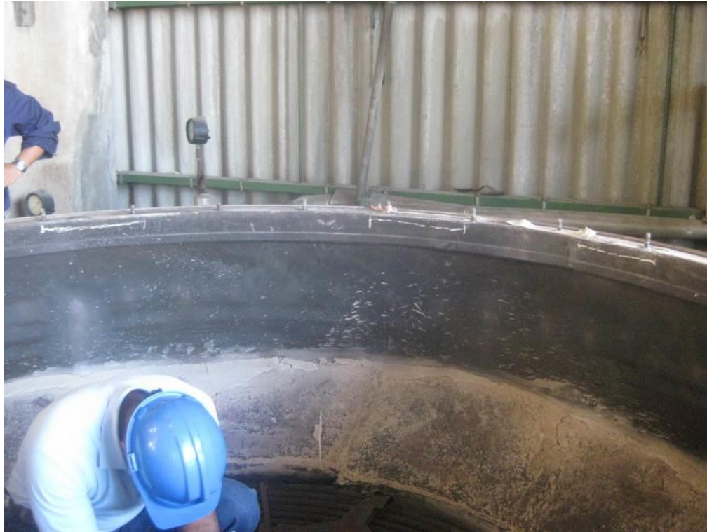
Foto 4: Parte interna de la parte superior del Reactor R1101.
